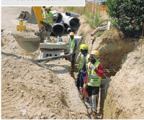
Turisti all'assalto delle fontane. Sopra in piazza di Spagna, a Roma. Sotto un cantiere a Padova
